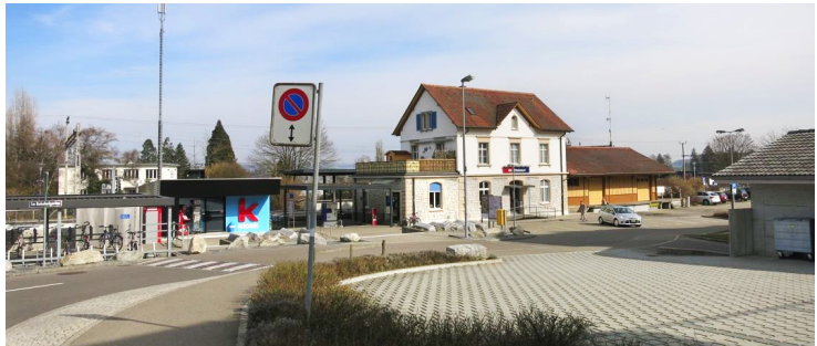
Abb. 16: Bahnhofplatz mit Bahnhofsgebäude (Quelle: PLANAR)
