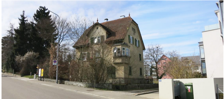
Abb. 15: Bahnhofstrasse/Bahnhofweg mit dahinterliegendem Zentrumspark (Quelle: PLANAR)
