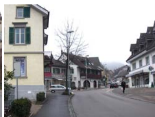
Abb. 41: obere Bahnhofsstrasse, historische Substanz, untergenutzt, EG mit Verkaufsgeschäften besetzt
