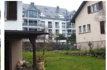
Abb. 54: Einfamilienhausparzellen Schwändistrasse in zentraler Lage
