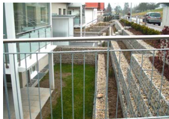
Abb. 17: massive Terrainabgrabungen in der W2/35
